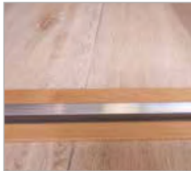
próg dębowy do ościeżnicy drewnianej
