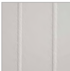
frezowanie na powierzchni skrzydła
