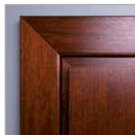
łączenie opasek pod kątem 45°
